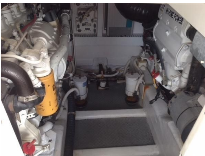
Motorisation 2x 460ch Caterpillar
